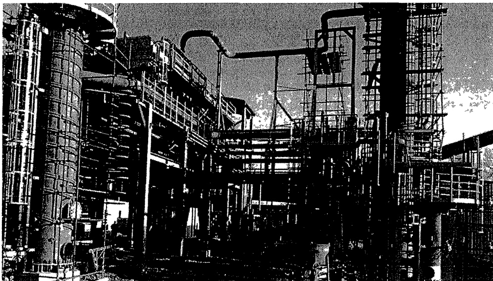
Zatvoreni sustav „Blow down“ na Koking postrojenju RNS-a
